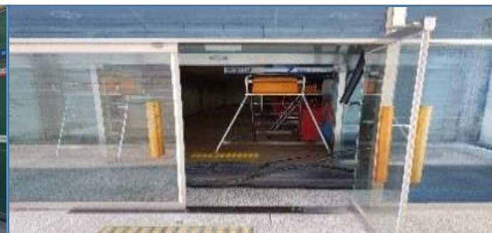
출입구 근처 적치물 방치의 잘못된 예 (출입구 앞 통로를 막은 적치물 방치)
