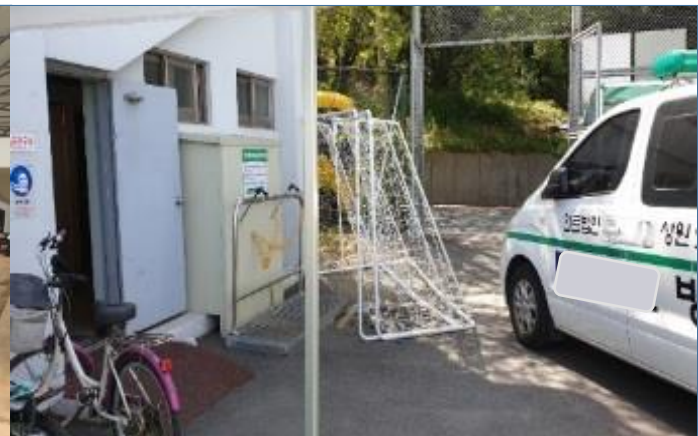
구급차 대기공간 마련의 잘못된 예 (적치물 방치로 위급상황 시 구급차 통행 제한)
